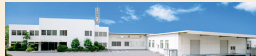
本社・物流センター・岡山支店
